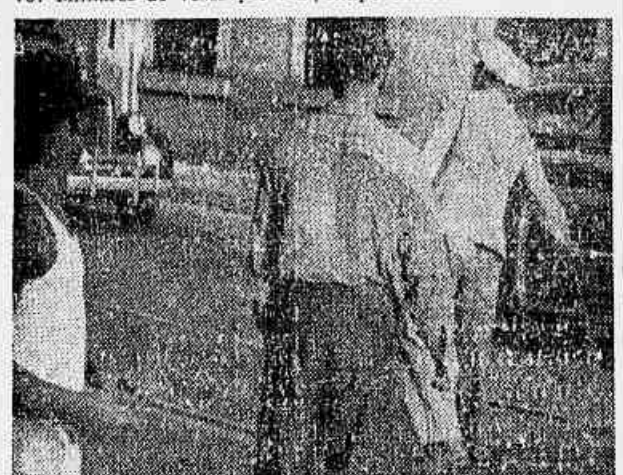
Milhares de vezes por dia os chaveiros repetem essa operação abrindo ou fechando os desvios dos trilhos
