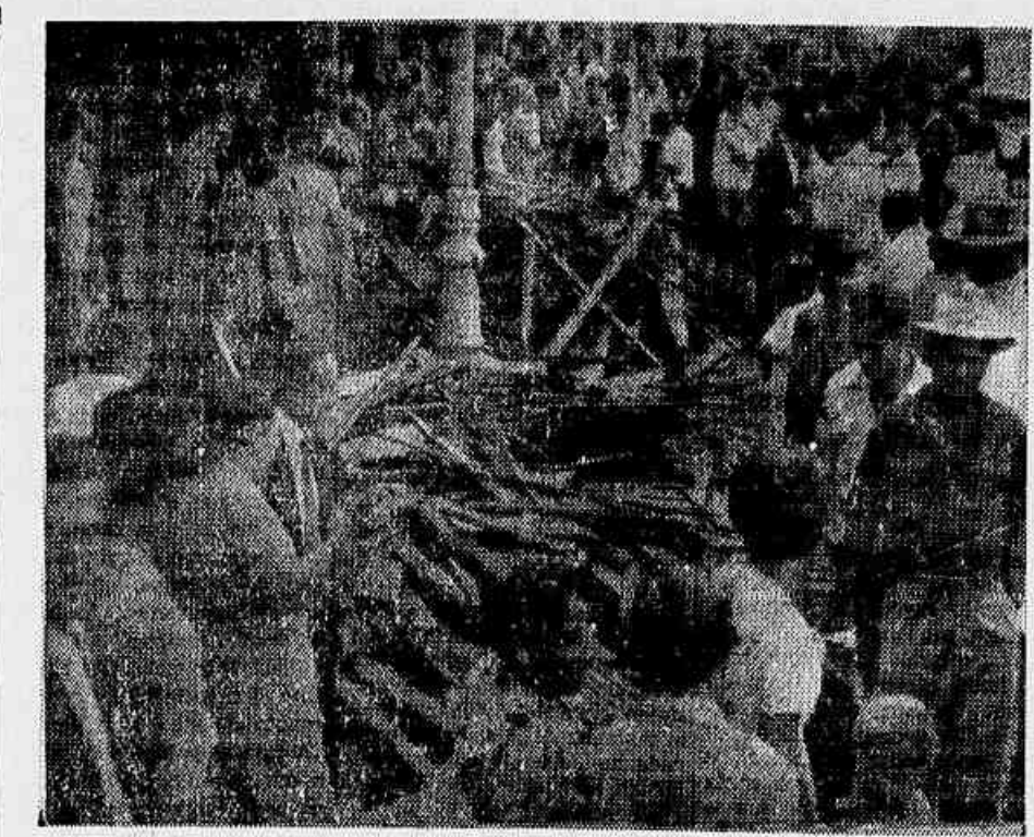
Durante todo o dia de ontem, sob a forte impressão causada pelo desastre, moradores do subúrbio estacionavam no local, verificando pelos escombros a extensão do sinistro e tentando comerciar. O povo não confia mais nos promessos dos homens da alta administração, mas insiste em reclamar segurança e respeito pela vida dos passageiros da Central.
