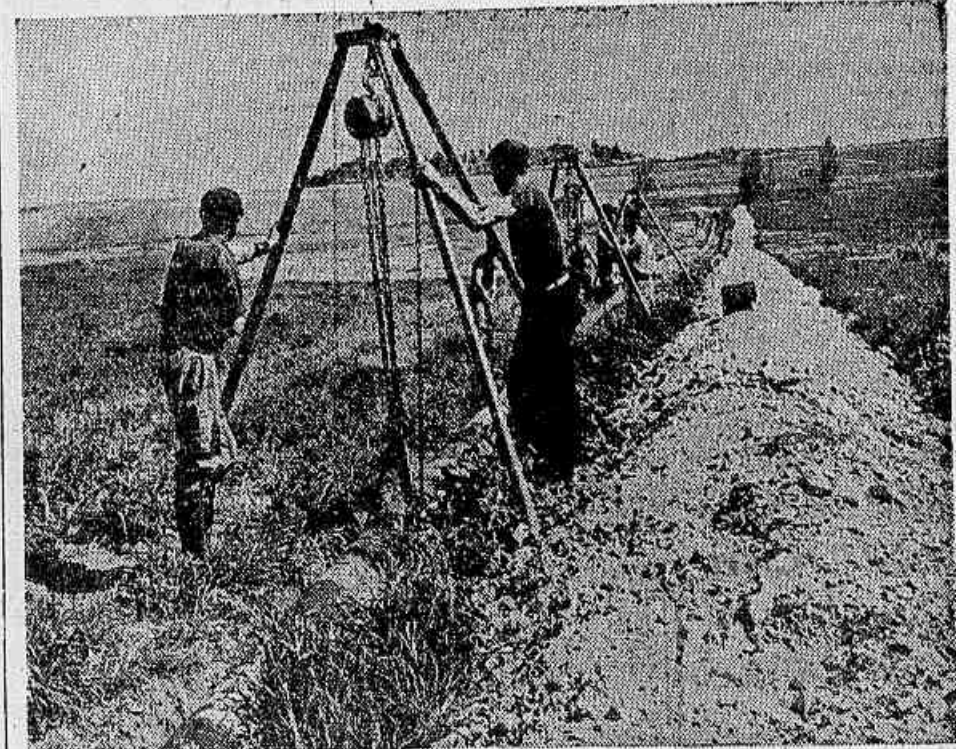
Perto de Bellica, na França, operários instalam um oleoduto para as forças de ocupação americana. (Fotos U.F.P.)
