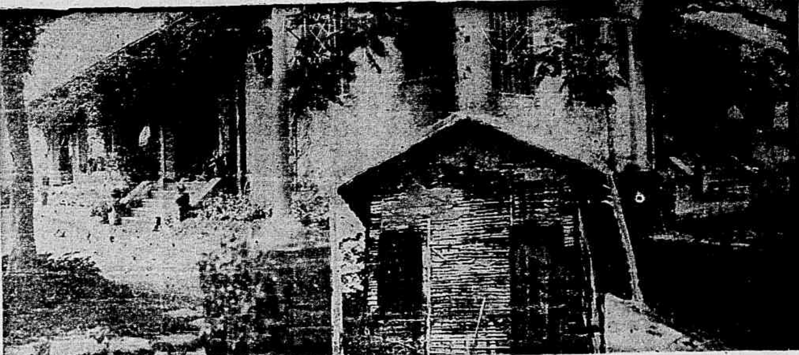
Na gravura vemos a mansão do superintendente da Light. Para se chegar a ela é preciso percorrer uma estrada particular, pavimentada, de cerca de dois quilômetros. Em montagem vemos, também, o cabre de um dos muitos trabalhadores da Light, encrustado numa favela do Rio de Janeiro
