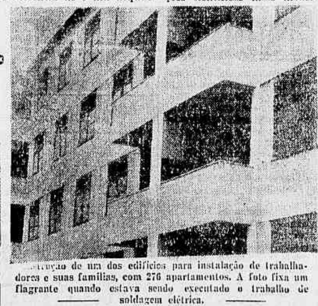
Um dos edifícios para instalação dos trabalhadores e suas famílias, com 276 apartamentos. A foto fixa um instante quando estava sendo executado o trabalho de soldagem elétrica.
