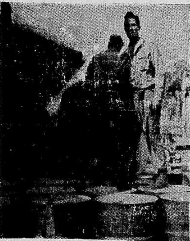
No Cais de inflamáveis, trabalhadores da «Atlantic» sobre tambores de gasolina, preparando-se para carregar uma chapa. Há cinco anos um desses tambores explodiu ao ser soldado, apesar de ter sido previamente lavado com água e dado como isento de vapores inflamáveis. Resultado: um dos operários teve ambas as pernas mutiladas.
