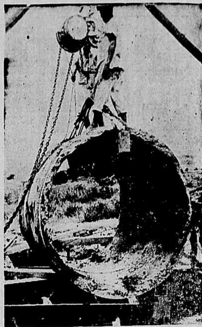
A PREFEITURA USOU na segunda adutora, que traz água do Ribeirão das Lajes, os tubos da companhia americana TETRACAP. O encanamento está atacado de uma corrosão violenta («stress corrosion»). Seis tubos já se romperam e em diversos lugares os tubos. O Instituto Nacional de Tecnologia condenou os tubos. O sr. Alim Pedro, como secretário da Viação e agora como prefeito, quer empregar os mesmos tubos. (Na foto um tubo rompido)
