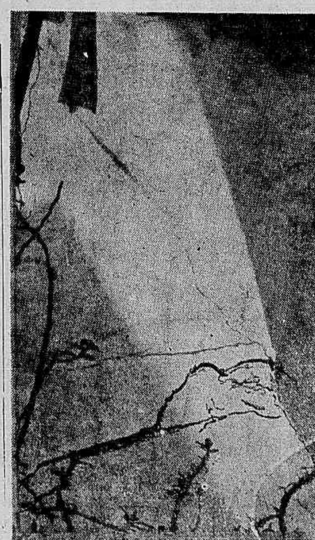
O piso de um dos andares do prédio da Rua Monte Alegre está no estado que o clichê demonstra. Rachaduras e fendas de alto a baixo
