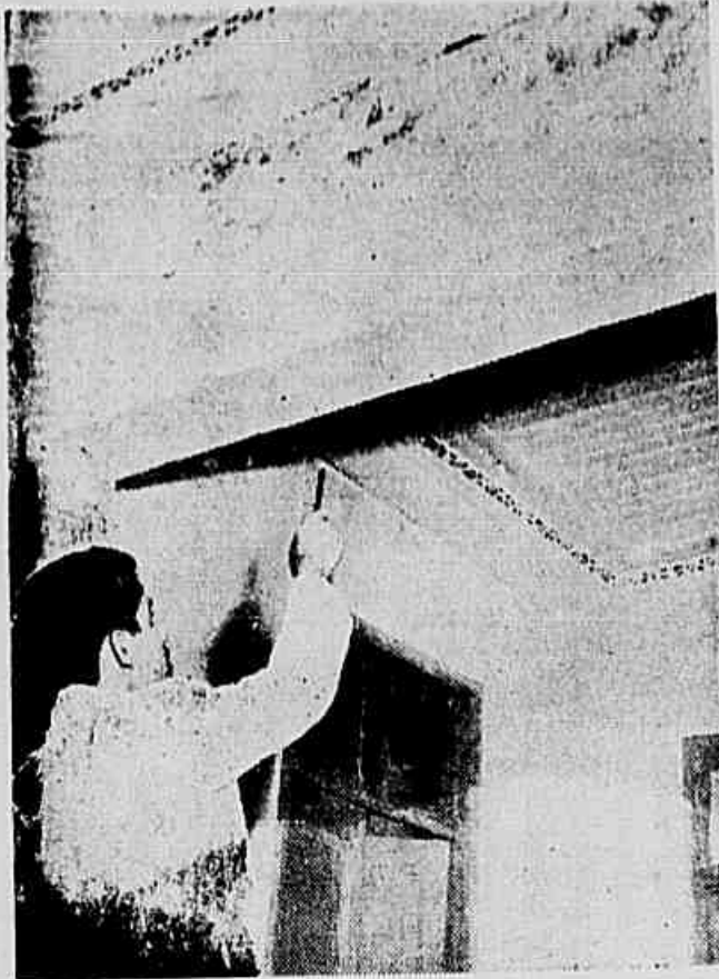
Pelo teto, a água se infiltra nas paredes do prédio e de tal maneira, que pedaços do reboco caem continuamente a qualquer vento mais forte
