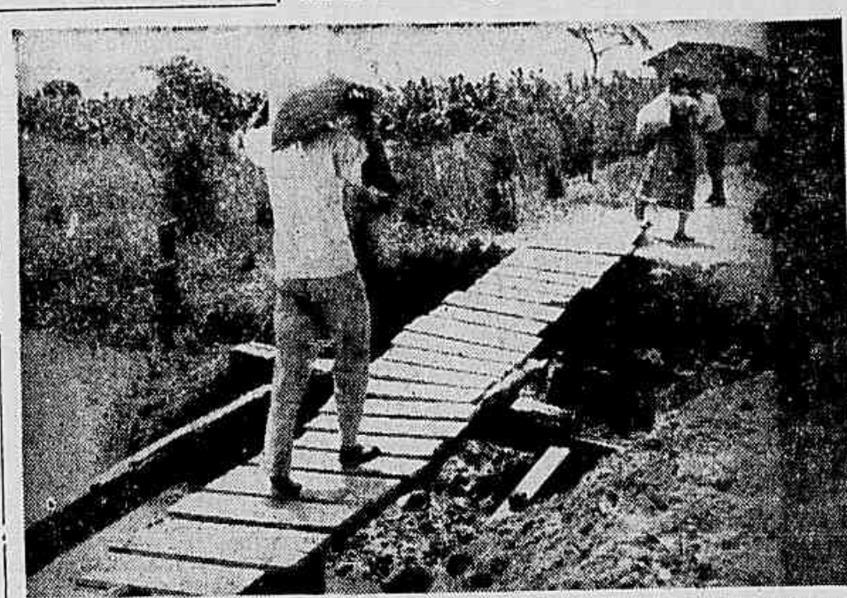
Trêcho da estrada cortada pelas águas da inundação. Foi necessário se improvisar ali uma ponte para os transeuntes
