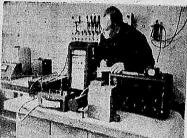
No Instituto Físico-Técnico da Academia de Ciências foram construídos alguns instrumentos, mediante os quais, com a ajuda dos isótopos radioativos, emitidos pelos raios, realiza-se o controle da densidade da polpa ou mescla transportada pelas dragas de aqueço. Na foto, o professor S. Starodubtsev regulando um instrumento
