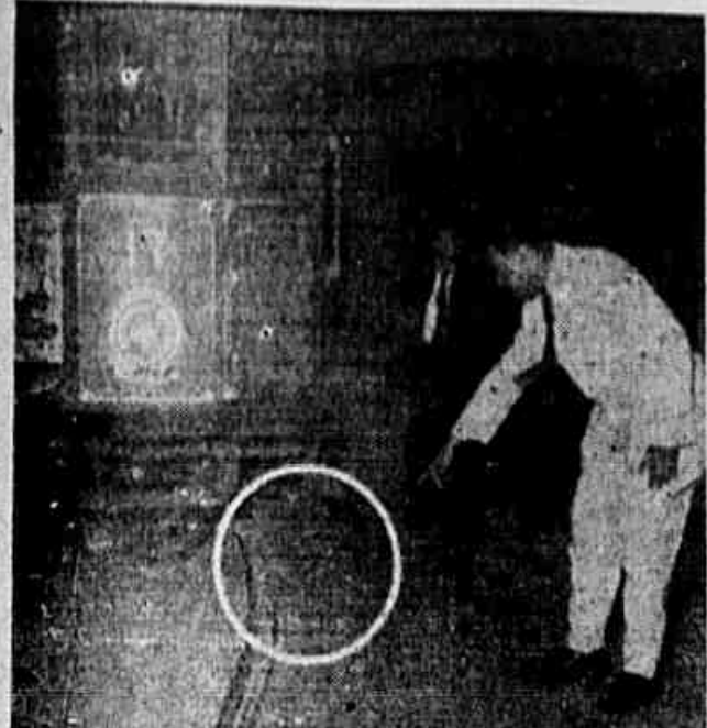
Bem na curva, no trecho apontado pelo sr. Jorge Cavadas, secretário do Sindicato de Carris, os trilhos estão afundados, o que poderá acarretar descarrilamentos, com graves consequências. Círculos como este, apontando falhas perigosas em trilhos, podem ser feitos às dezenas em fotos das linhas de bonde em Santa Teresa
