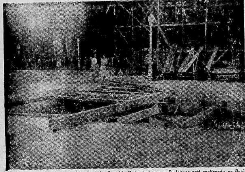
Na foto, vemos um aspecto das obras da Avenida Perimetral, que a Prefeitura está realizando na Praça 15, com um dos seus buracos inteiramente exposto, à espera da carioica incauto
