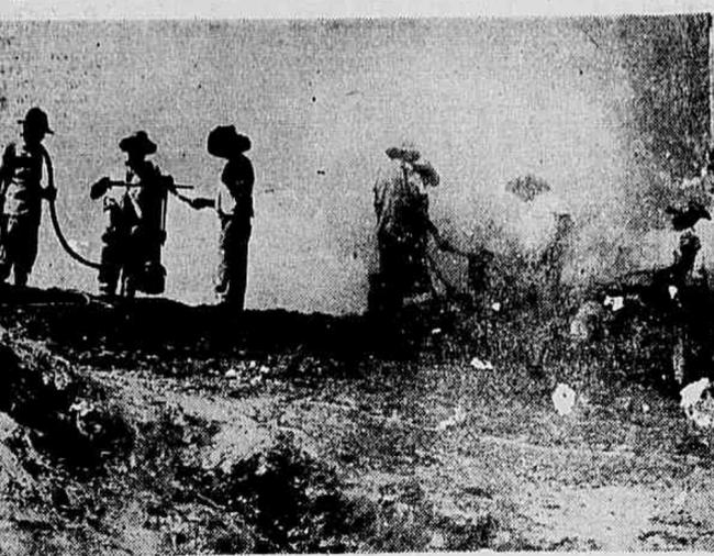
A troca de alguns miseráveis litros de feijão e farinha os flagelados do nordeste constroem o açude do Banabuiú. Na foto, trabalhadores manejando os pesados bateadores, utilizados na grande obra
