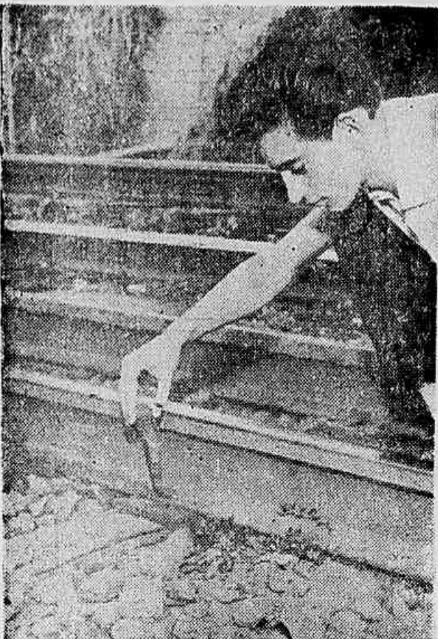
Aqui, o parafuso que prende o trilho ao dormente que se apresenta solto. A madeira apodreceu, em consequência, e não foi renovada.
