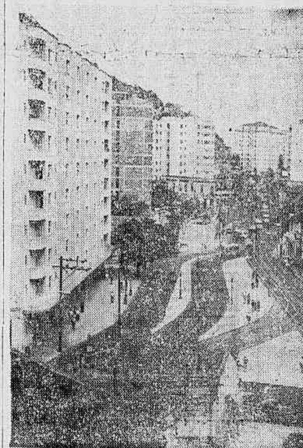
Arranjo da "Garganta" O sr. Sá Freire Alvim esteve em visita aos trabalhos de demolição dos prédios desapropriados no Largo do Humaitá. Estes demolições estão sendo feitas pela SURSAN, que vai alargar a "garganta" formada pelo encontro da Rua Voluntários da Pátria com a Rua Humaitá, no local, facilitando assim o escoamento do trânsito para o Jôquei e Glória. Na foto, censo um aspecto do local onde estão sendo feitas as demolições.
