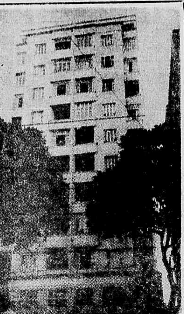
Edifício do prédio 336, da rua do Calce, de propriedade do IAPETC, onde a luz foi cortada devido ao fato do Instituto não pagar a Light
