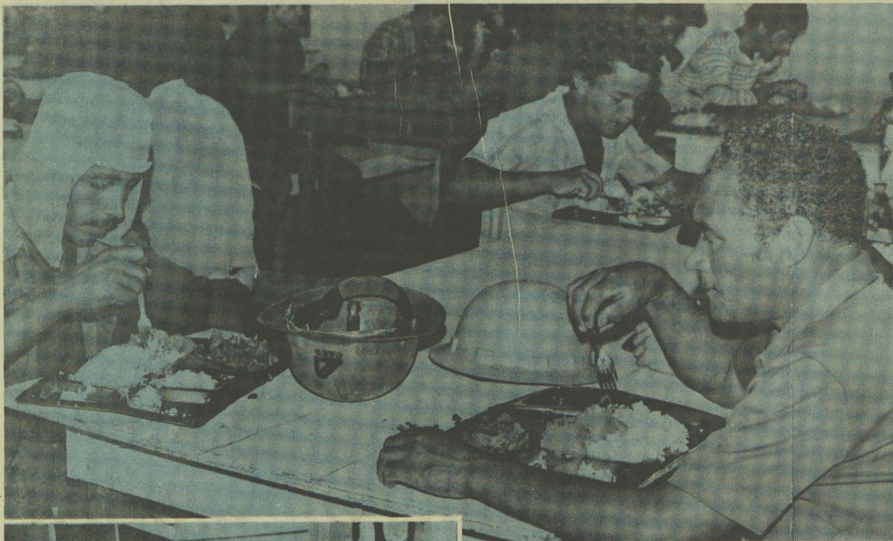
Um ambulatório da obra, e o capacete usado para beber
