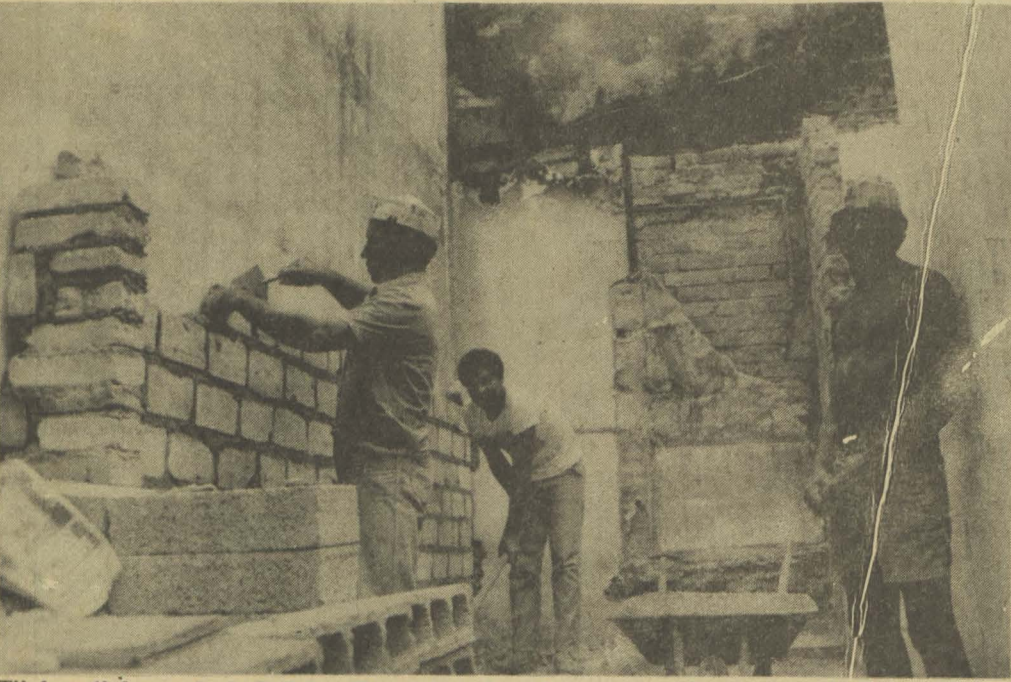
Tijolo a tijolo a sede da Tribuna Operária vai sendo reconstruída com o apoio dos operários
