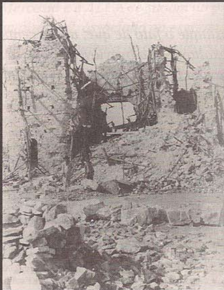
Ruínas da Igreja de Santo Antônio
