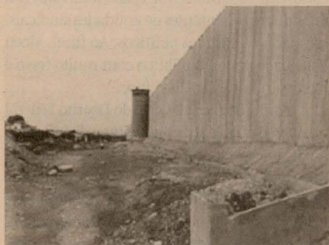
Trecho do muro em Qalqiliya
