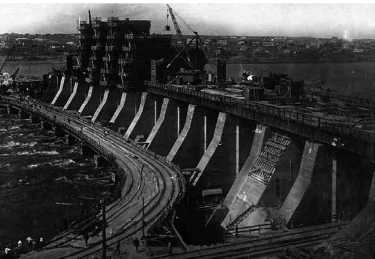
Obras da represa hidrelétrica sobre o Rio Donetz
